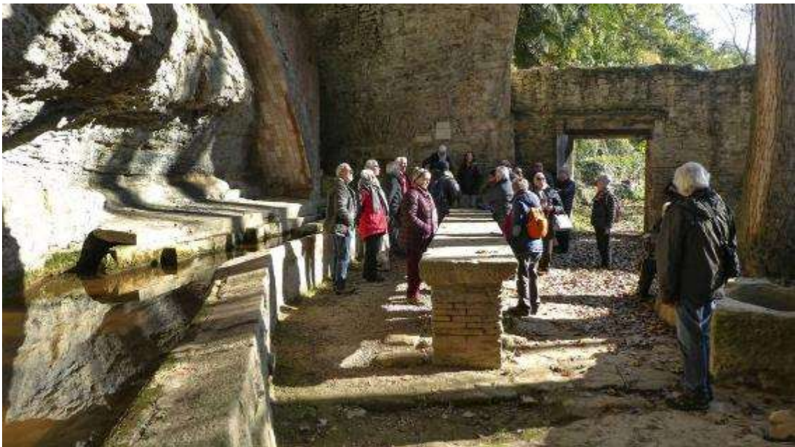
Interior del rentador de la llana. Planta inferior.
